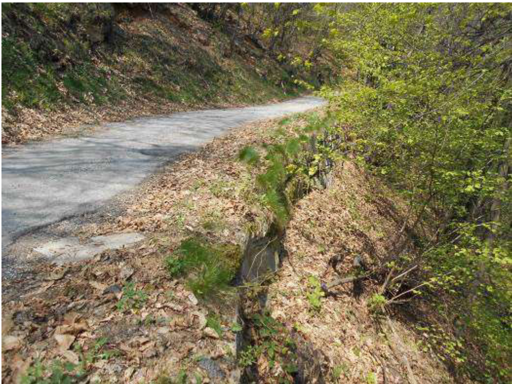
Intervento 2 - Vista del muro esistente in loc. Moloire.
