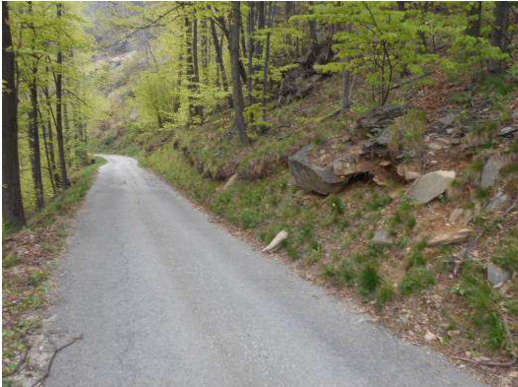
Intervento 3 – Vista da monte verso valle dell'area di intervento.
